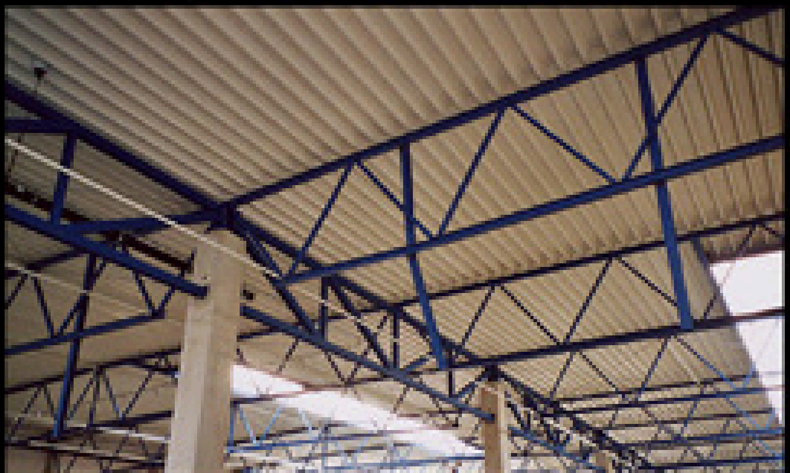
Die Dachkonstruktion im Inneren der Produktionshalle
